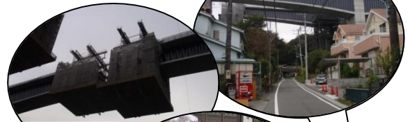
取材時は建設途中
